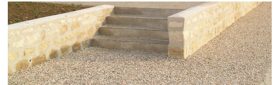
Muret pierre calcaire, escalier béton clair, trottoir béton désactivé
