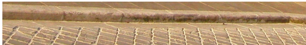
Bordures calcaires, fil d'eau calcaire, dallage trottoir gré et pavage rue en gré
