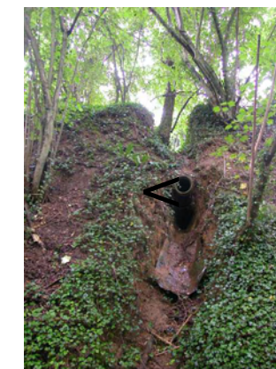
Sortie pluviale directement dans la ravine
