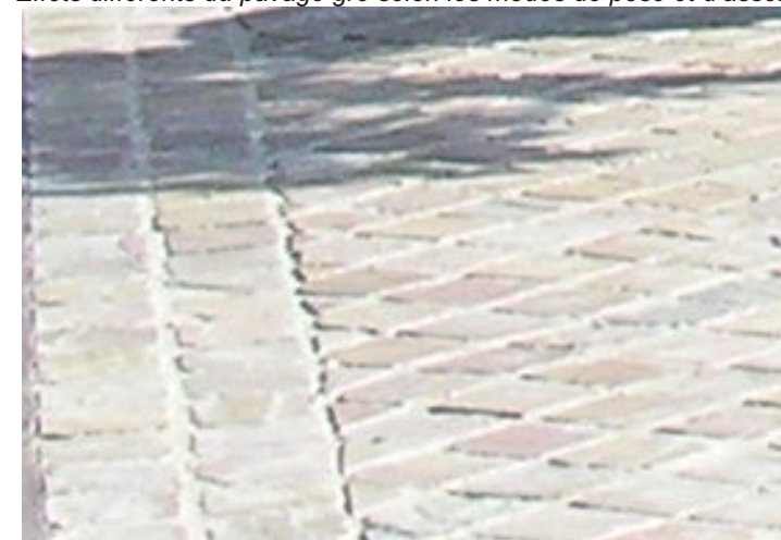
Effets différents du pavage gré selon les modes de pose et d'assemblage
