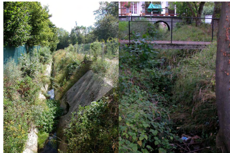
Exutoire à ciel ouvert
